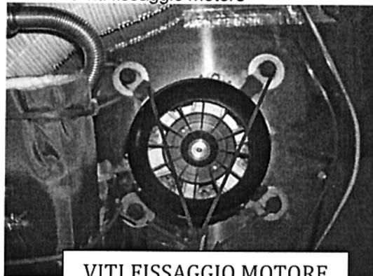
VITI FISSAGGIO MOTORE
